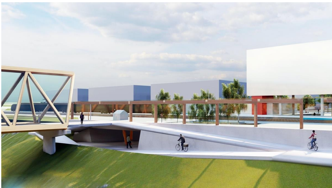
Figur 5-3 Elvebredd på sørside med rampe og trapp
