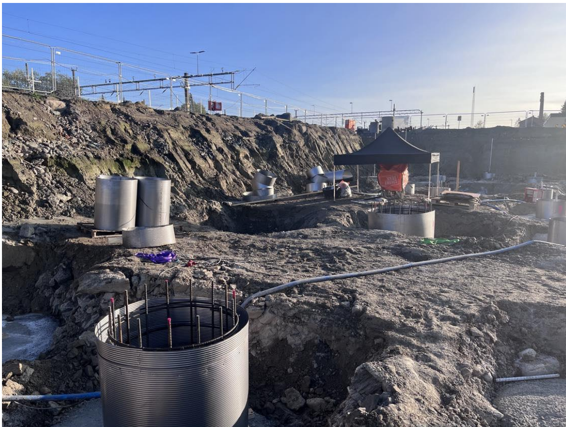
Figur 30 Bilde fra byggegrop Elvebredden oktober 2023 (foto: Harald Ihler). Tørre og faste masser. Gravedybde til fjell, ca. 5m.
