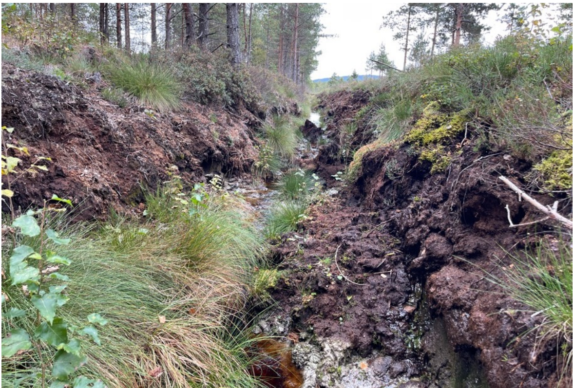
Figur 4. Flere av grøftene i ytterkant av myra er både svært brede og dype, og antas å ha en svært effektivt drenerende effekt. Stedvis var enkelte av grøftene opp mot 3 meter dype. Grøften på bildet er fra den nordvestre delen av utredningsområdet, like nord for den store konsentriske høymyra. Endringsgjeld på lang sikt fra en slik grøft er vanskelig å estimere, men det er klart at det vil ha en stor påvirkning på hydrologien på både kort og lang sikt. Foto: Knut Hessen.
