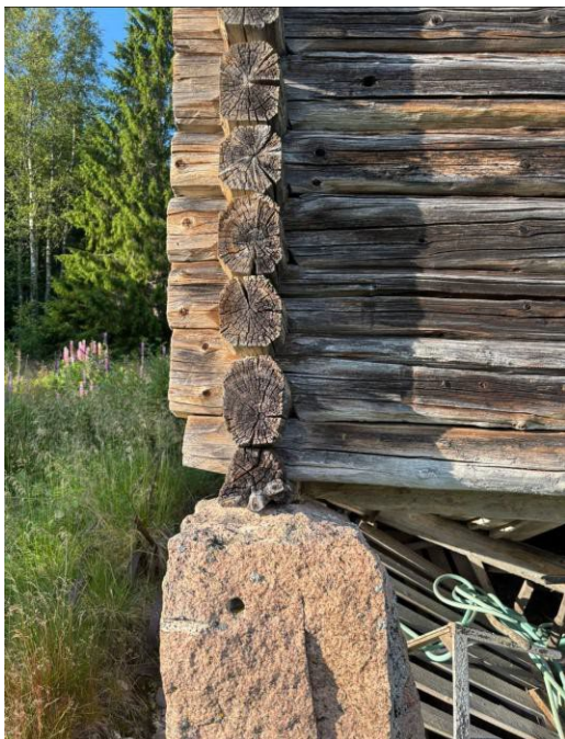
Bilde 30. Knuten på stabburet, Nordre Furuberget.
