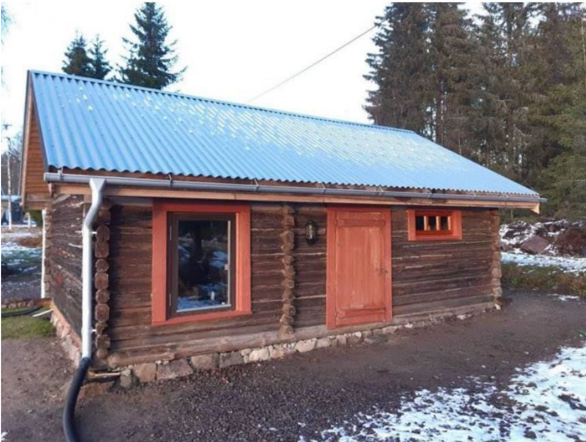
Bilde 17. Sommerfjøset på Oppistua etter restaurering, fasade mot vest og sør.
