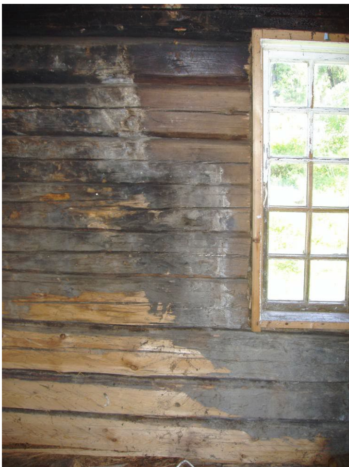
Bilde 4. Ofte er sporene av den skogfinske byggeskikken vanskelig å tyde i en bygning. Her ser vi konturene etter en røykovn. Området ovenfor er sotete. Sotete stokker er nok den vanligste indikatorene på at en bygning kan være av skogfinsk opphav. Lindalstorp, Grua kommune.
