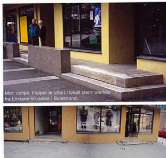
Under: Prinsipp for å ta opp høydeforskjell inn mot bygg. Vangen bør ha konstant høyde.
