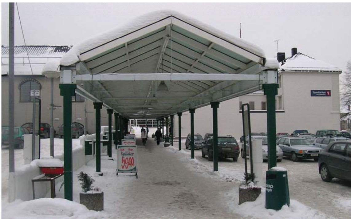
Bildet viser dagens situasjon, sett mot vest.
