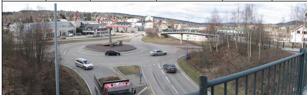
7.3 Bruene over Rv 20 og Rv 2 er en fin og oversiktlig adkomst til sentrum for syklistene østfra og sørfra. Her sett fra brua over Rv 20 med Brugata rett fra og gang og sykkelbru over Rv 2 til høyre
