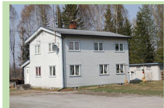
Våningshus på Roverud av en type funkis som ble svært vanlig. Foto: Hans Johnsson.
