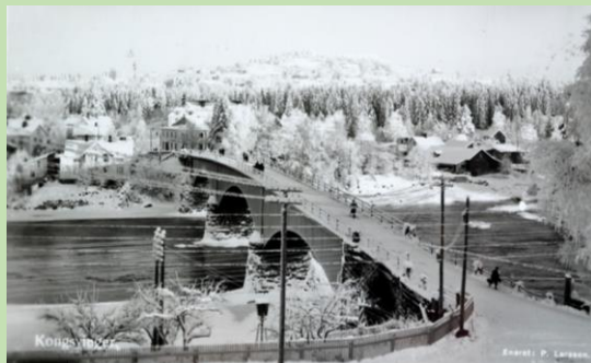
Brua over Glomma. Bildet tatt før 1940.
