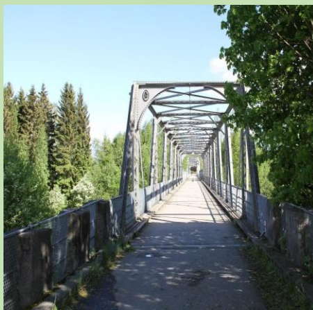
Skarnes bru oppført 1885. Foto: Hans Johnsson.
