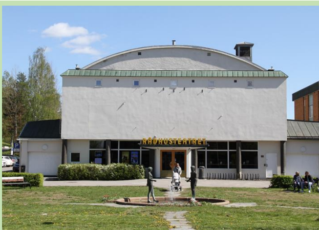
Rådhuset, Kongsvinger. Ved restaureringen var bevaring av de verdibærende elementene i eksteriøret viktig å bevare. Foto: Hans Johnsson
