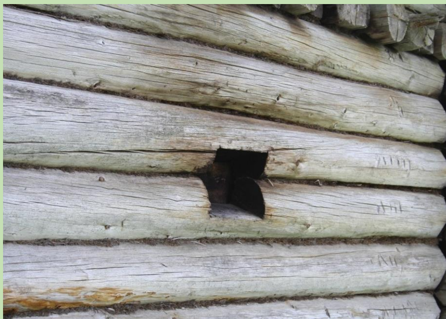
En bygning har mye å fortelle. Ved å lære seg å tyde sporene lærer man seg mye om en bygning, som for eks. at denne bygningen sannsynligvis er flyttet. Badstua på Nordre Varaldskogen, Kongsvinger. Foto: Hans Johnsson
