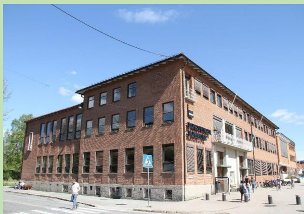
Rådhuset, fasade mot Storgata. Foto: Hans Johnsson.
