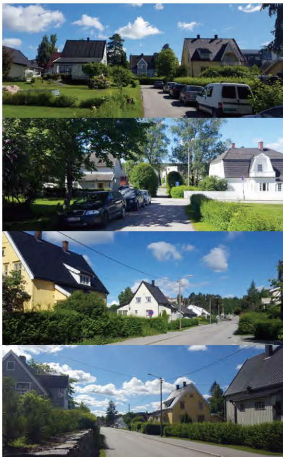
Hus som bør vurderes bevart langs midtre del av Fjellgata, Juells gate og midtre del av Parkvegen. Foto: Kongsvinger kommune
