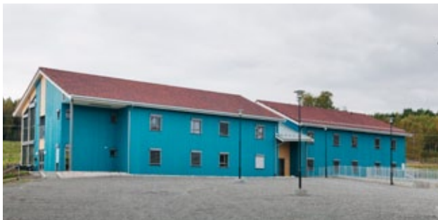
Arkitekt Trond Sundby, Arkitektlaget AS, Kongsvinger
